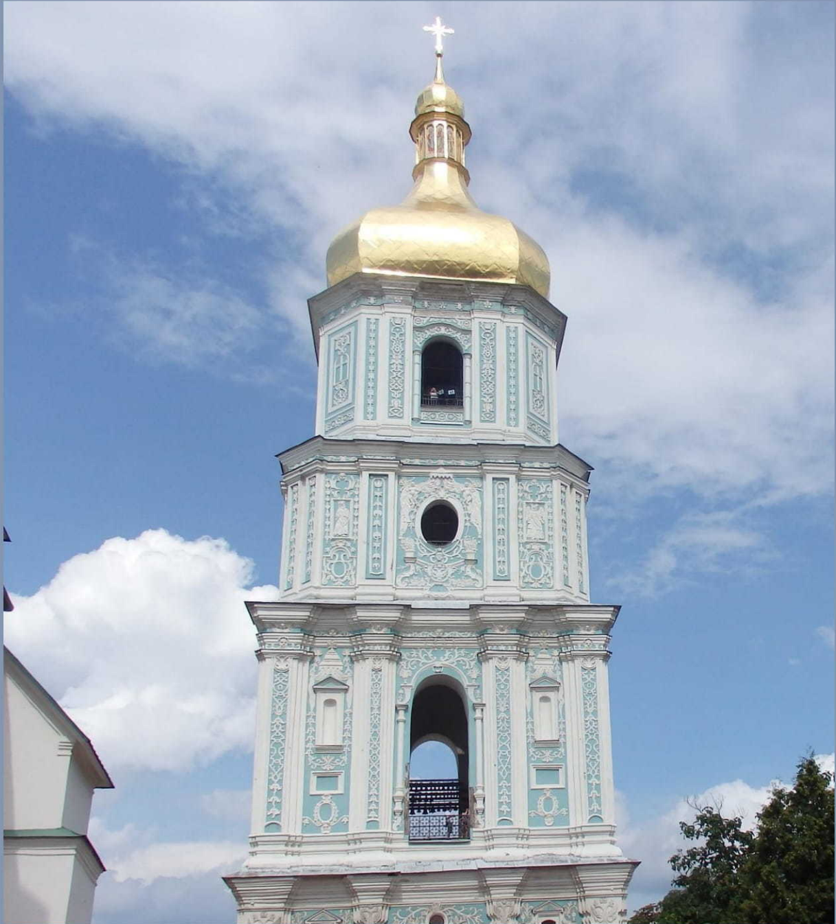
Dzwonnica Soboru Mądrości Bożej w Kijowie – XVIII w.
